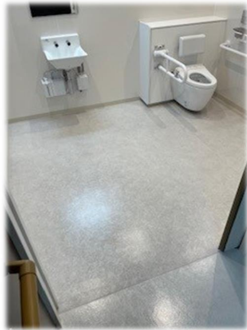
車いすトイレ(室内) ※床面全面に「ころやわ」を設置
